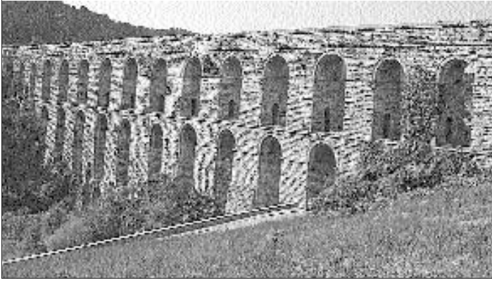
Kırkçeşme su tesislerinden Kovukkemer (Kırkkemer)
